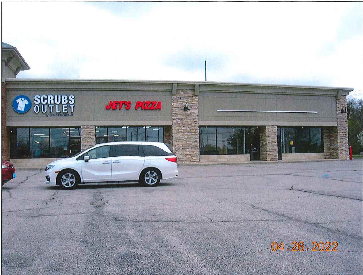
View of future tenant space
