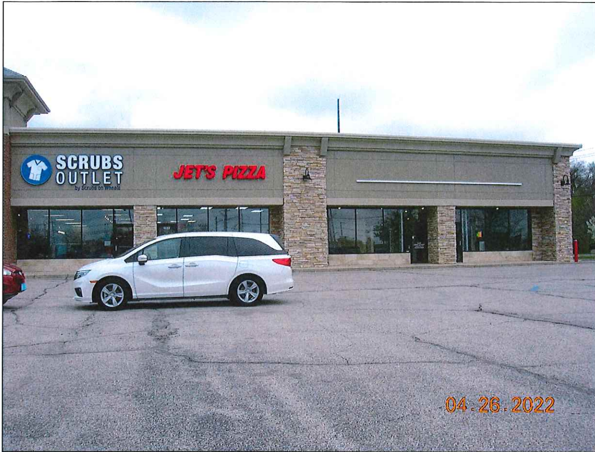
View of future tenant space
